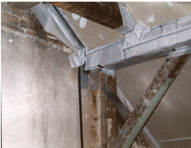
Bild 7.3.4.9.: Anschluss einer Dampfbremse an einer Mittelpfette
