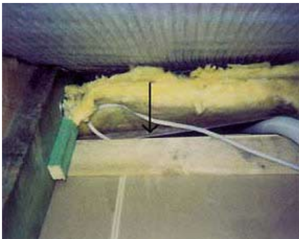
Bild 7.3.4.11. : Fehlerhafte Dampfbremse
