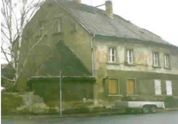
Bild 7.5.5.: Putzschäden wurden ausgebessert und ein Zementkalkanstrich aufgetragen.
