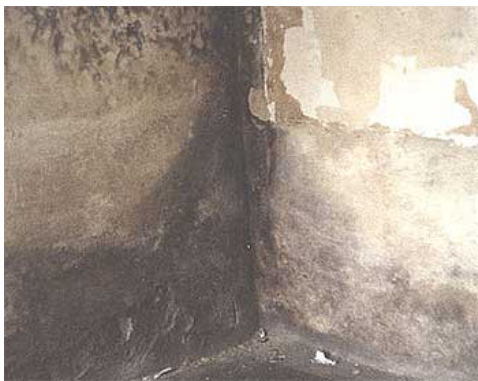
Bild 7.3.2.7.: Hier wird eine typische Außenecke gezeigt, neben altersbedingten Putzschäden erkennt man gut die schimmelpilzbefallene Wandfläche.
