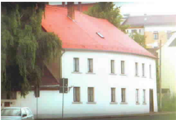
Bild 7.5.5.: Putzschäden wurden ausgebessert und ein Zementkalkanstrich aufgetragen.
