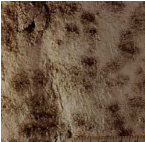
Bild 6.4.2.: Zersetzung der Raufasertapete über den Fußboden an der Außenwand
