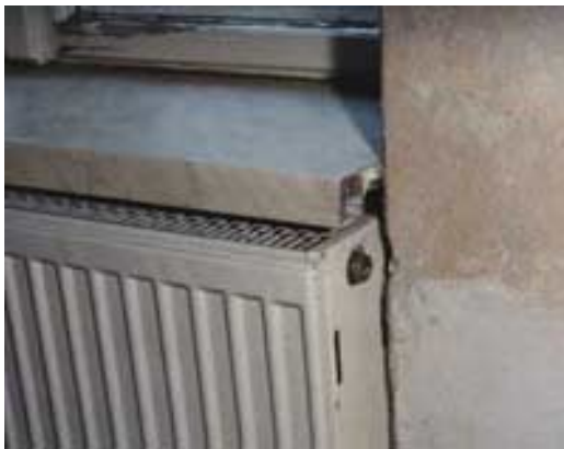
Bild 7.3.6.7.: Beispiel einer falschen Heizkörperanordnung, überstehenden Fensterbank
