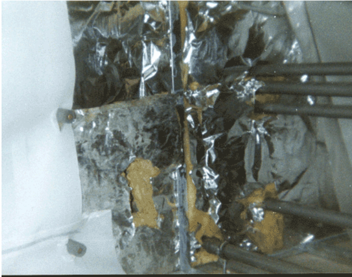
Bild 7.3.4.6.: Dämmung und Dampfbremse hinter der Abseitwand
