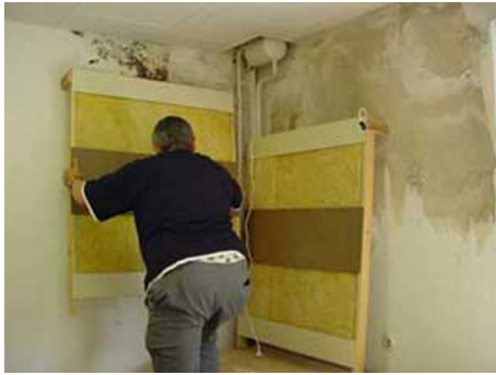
Bild 8.1.2.: Versuchsphase zur Trocknung einer durchfeuchteten Wand mithilfe der Infrarotstrahlung. [104]
