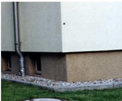
Bild 7.3.2.8.: Eckansicht einer äußeren Wärmedämmung
